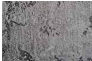
Τεχνική άγριας όψης σκυροδέματος
