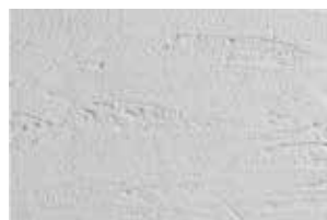
Τεχνική λείας όψης σκυροδέματος
