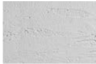
Τεχνική λείας όψης σκυροδέματος
