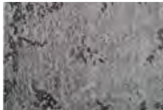
Τεχνική άγριας όψης σκυροδέματος
